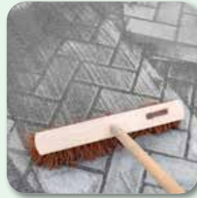
Anschließend nachsanden und erneut abrütteln. Danach rückstandsfrei abfegen und ggf. Fasen freilegen
