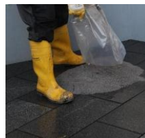
Vakuumbutel aufschneiden und frisches Material sofort gleichmäßig auf der nassen Belagsoberfläche verteilen.
