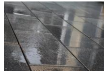
Steinoberfläche und Fugenflanken vor der Verfugung kräftig vornässen.
