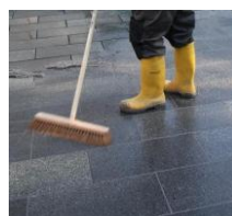
Mörtelreste mit einem weichen Besen und leichtem Wasserstrahl vollständig von der Belagsoberfläche entfernen.
