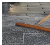
Prima 1K Pflasterfugenmörtel mit einem Gummischieber unter Druck in die Fugen einarbeiten.
