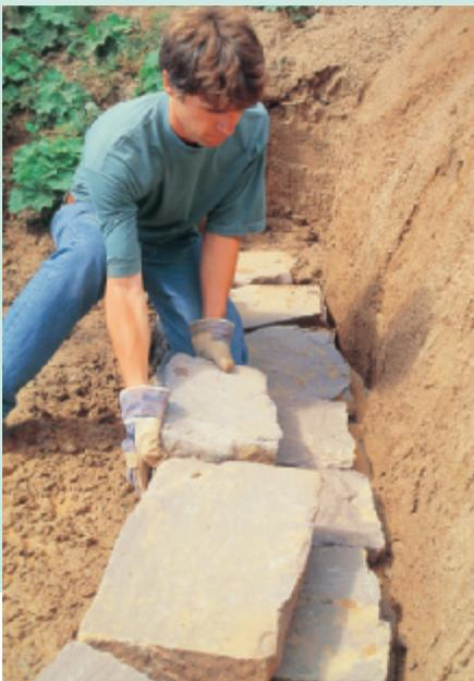
**3** Nun bringen Sie Lage für Lage eine etwa 30 bis 40 cm dicke Schicht Frostschutzkies in den entstandenen Graben ein. Die Oberkante dieser Schicht sollte schließlich etwa 10 cm unter dem Gelände liegen. So wirkt die Mauer später nicht aufgesetzt, sondern so, als wäre sie aus dem Boden herausgewachsen. Verdichten Sie die Kiesschicht mit einem motorgetriebenen Rüttelstampfer oder einem Handstampfer: Der Kiesunterbau darf unter dem Gewicht der Steine nicht nachgeben.
